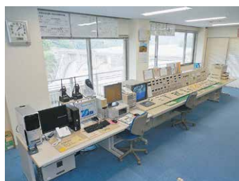
輝北ダム管理所（竣工20年経過）
