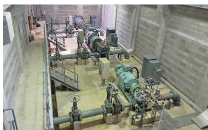
高岡揚水機場（竣工28年経過）
