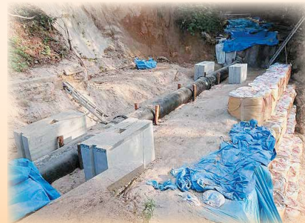
応急工事完了
