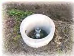
○給水栓設置 費用は無料です。
