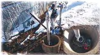
給水栓破損
