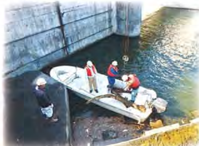
ダム流木撤去
