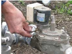
フィルターや取水バルブから水を抜きます
