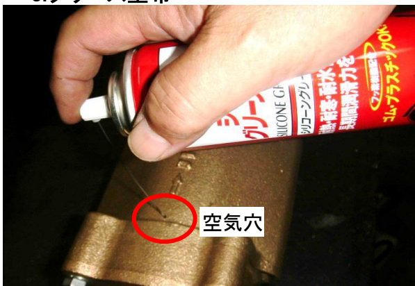
写真3. ノズル差込状況
